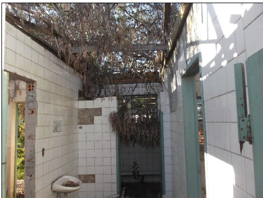
Foto 18 - Sala 04A do Prédio 01.
