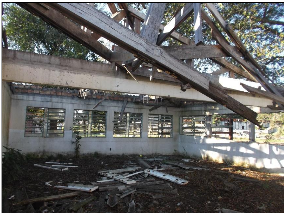
Foto 17 - Sala 01 do Prédio 01.
