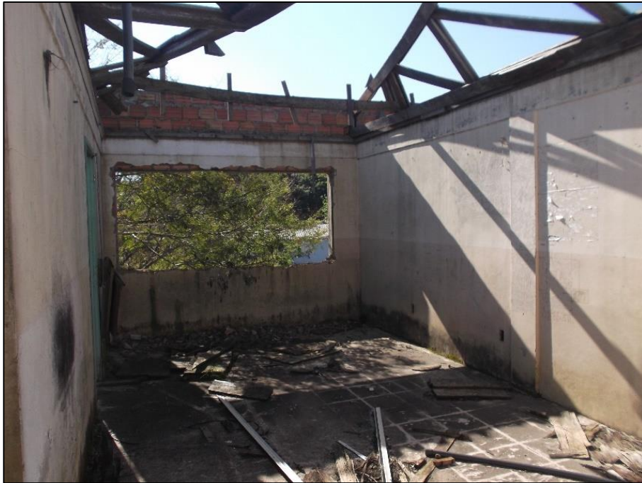
Foto 34 - Sala 37 do Prédio 01.
