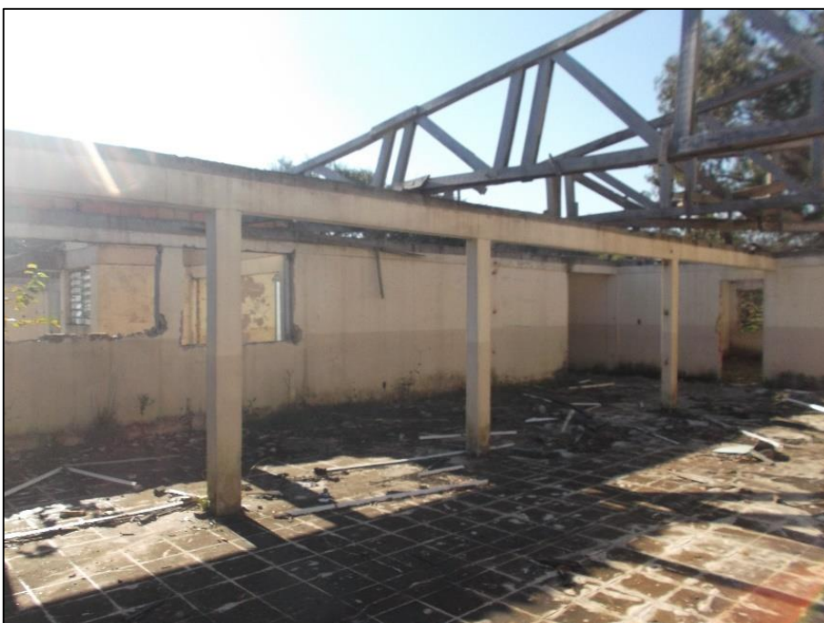
Foto 24 - Sala 12 do Prédio 01.
