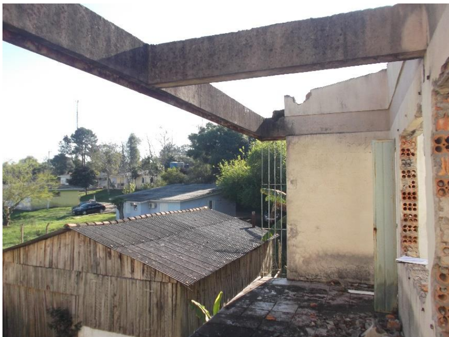
Foto 21 – Sacada 03 do Prédio 01.
