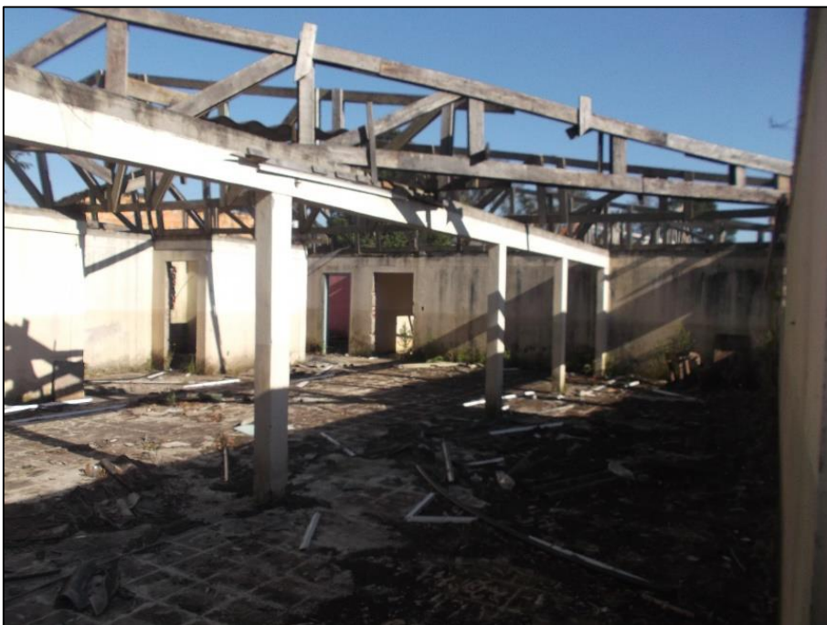
Foto 23 - Sala 12 do Prédio 01.
