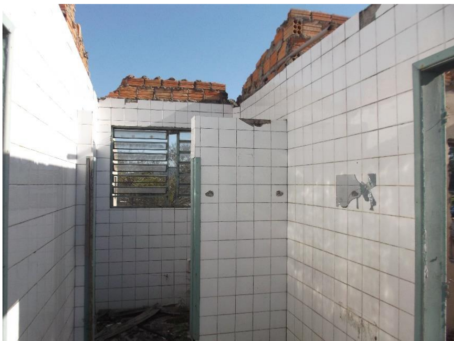
Foto 22 - Sala 10A do Prédio 01.
