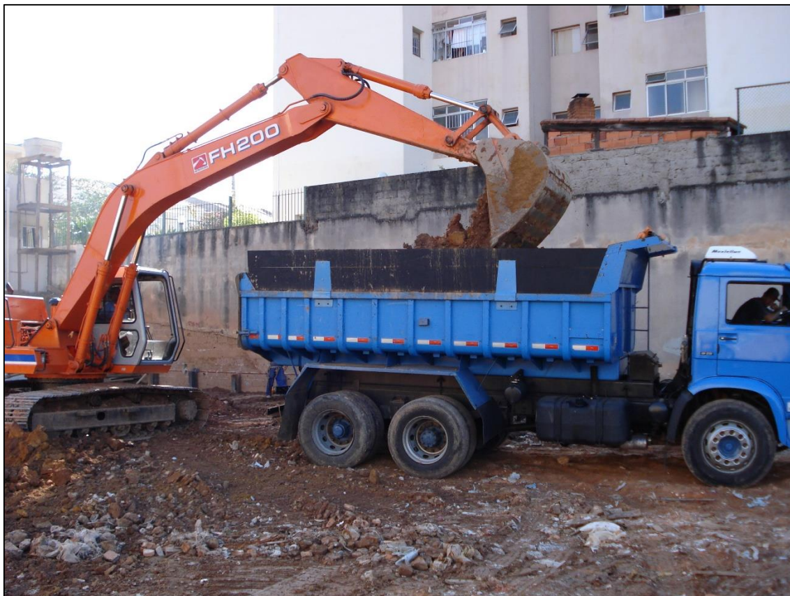
Foto 16 – Escavadeira carregando caminhão basculante.
