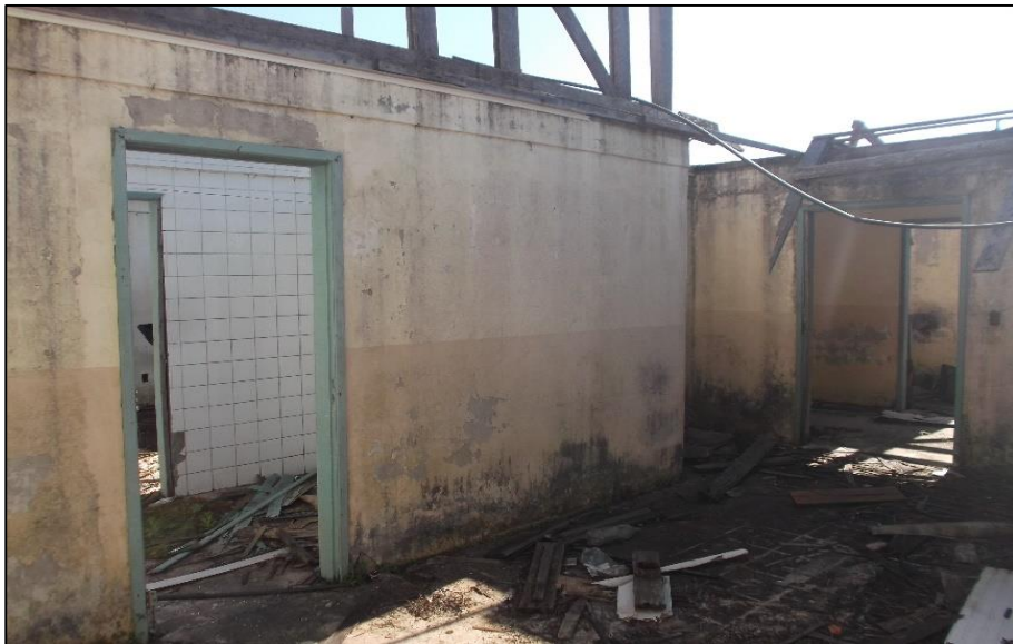
Foto 31 - Sala 42 do Prédio 01.
