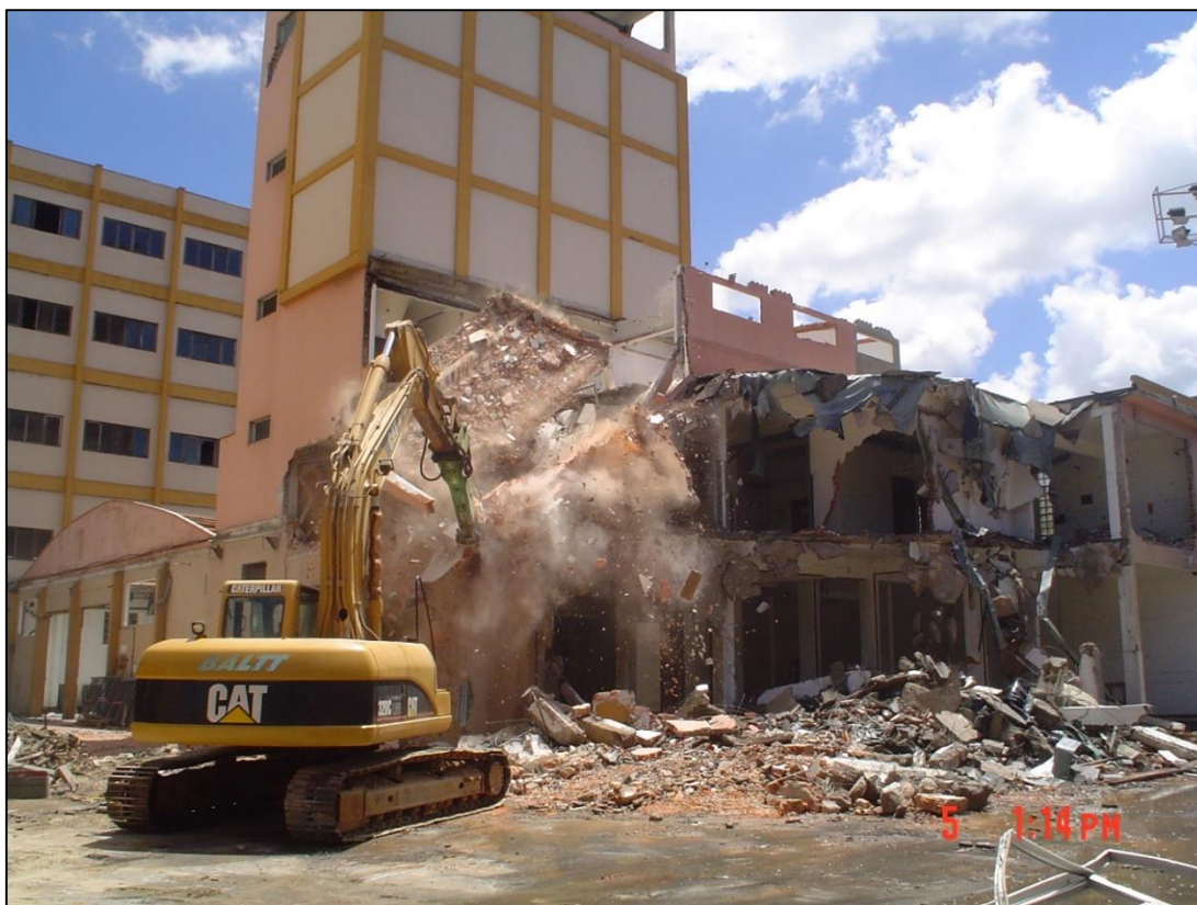
Foto 9 – Escavadeira com martelo rompedor hidráulico acoplado.
