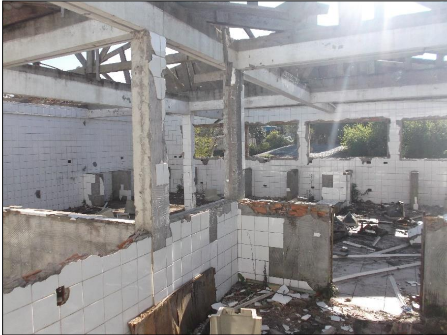
Foto 29 - Sala 21 do Prédio 01.
