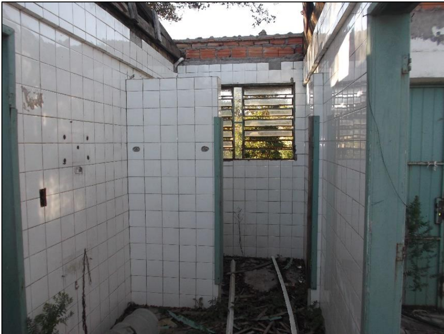
Foto 20 - Sala 36A do Prédio 01.
