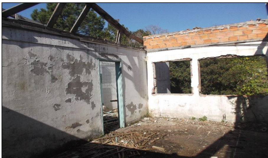
Foto 33 - Sala 43 do Prédio 01.
