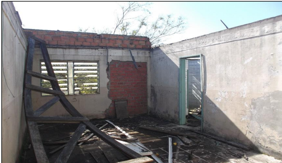
Foto 35 - Sala 41 do Prédio 01.
