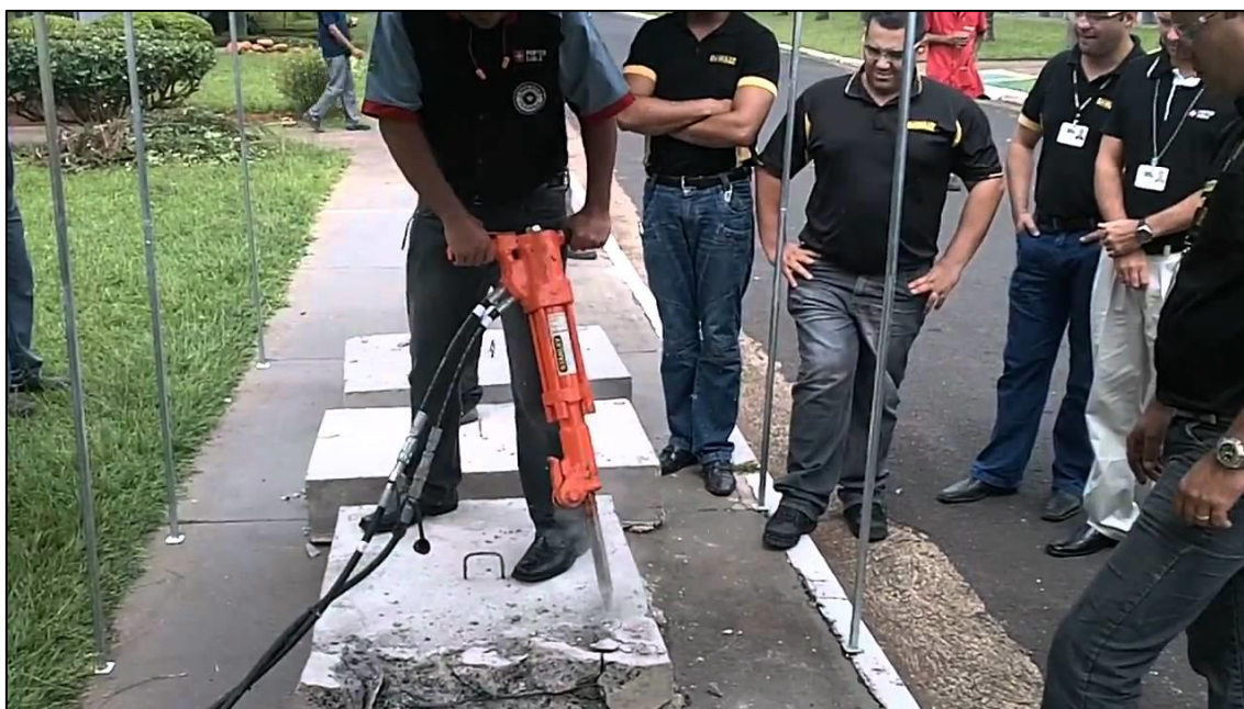
Foto 10 – Martelo rompedor hidráulico operado manualmente.
