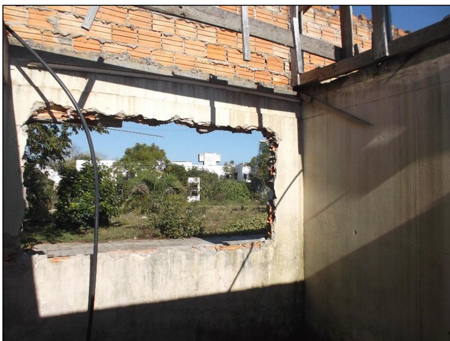
Foto 27 - Sala 17 do Prédio 01.
