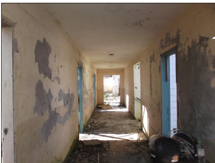
Foto 28 – Sala 20 do Prédio 01.
