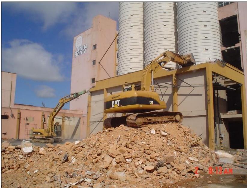
Foto 12 – Escavadeiras rompendo e picando a estrutura de concreto armado e alvenarias.
