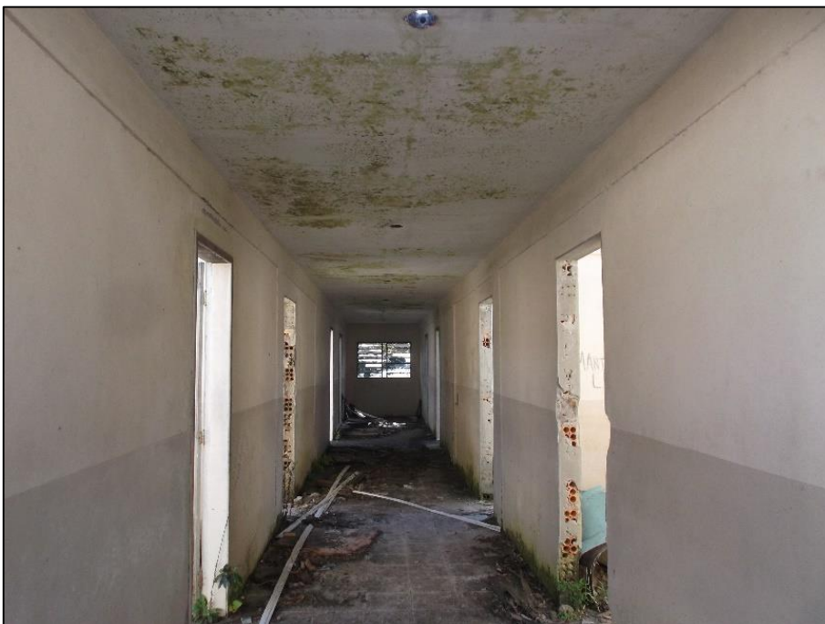
Foto 25 - Sala 13 do Prédio 01.
