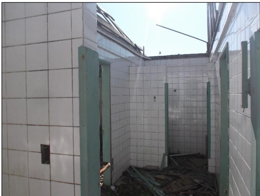
Foto 32 - Sala 42A do Prédio 01.
