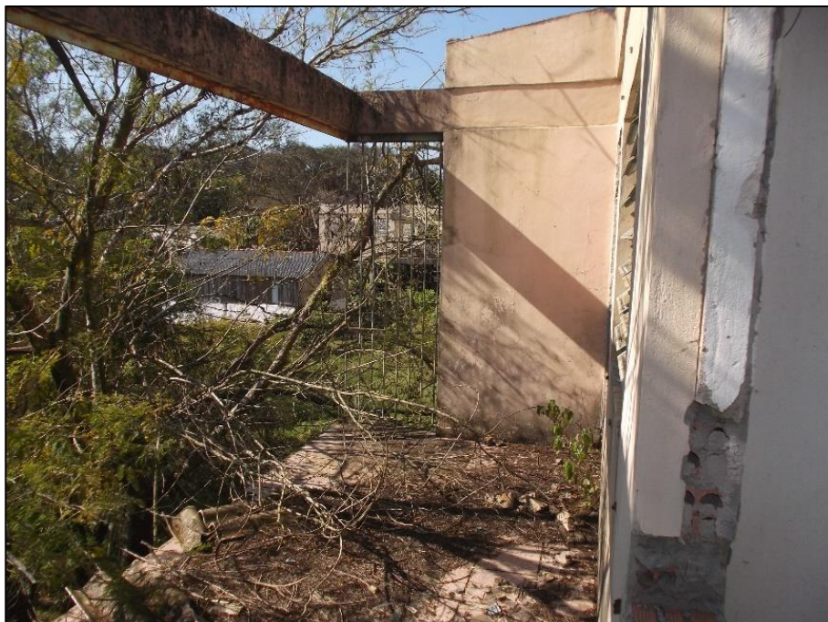
Foto 36 – Sacada 05 do Prédio 01.
