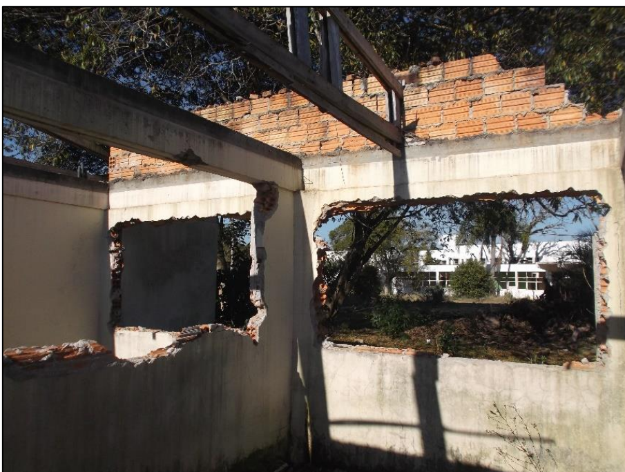
Foto 26 – Sala 15 do Prédio 01.
